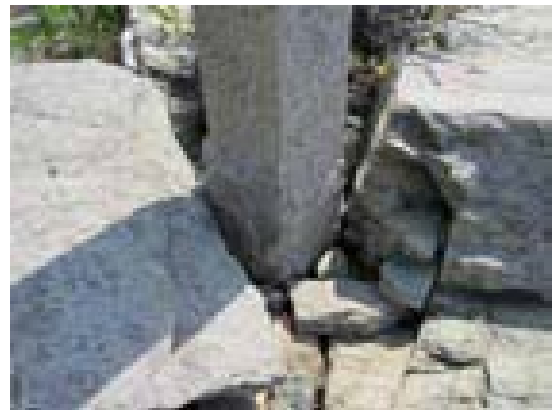
写真 109 第十六号 基礎部分
