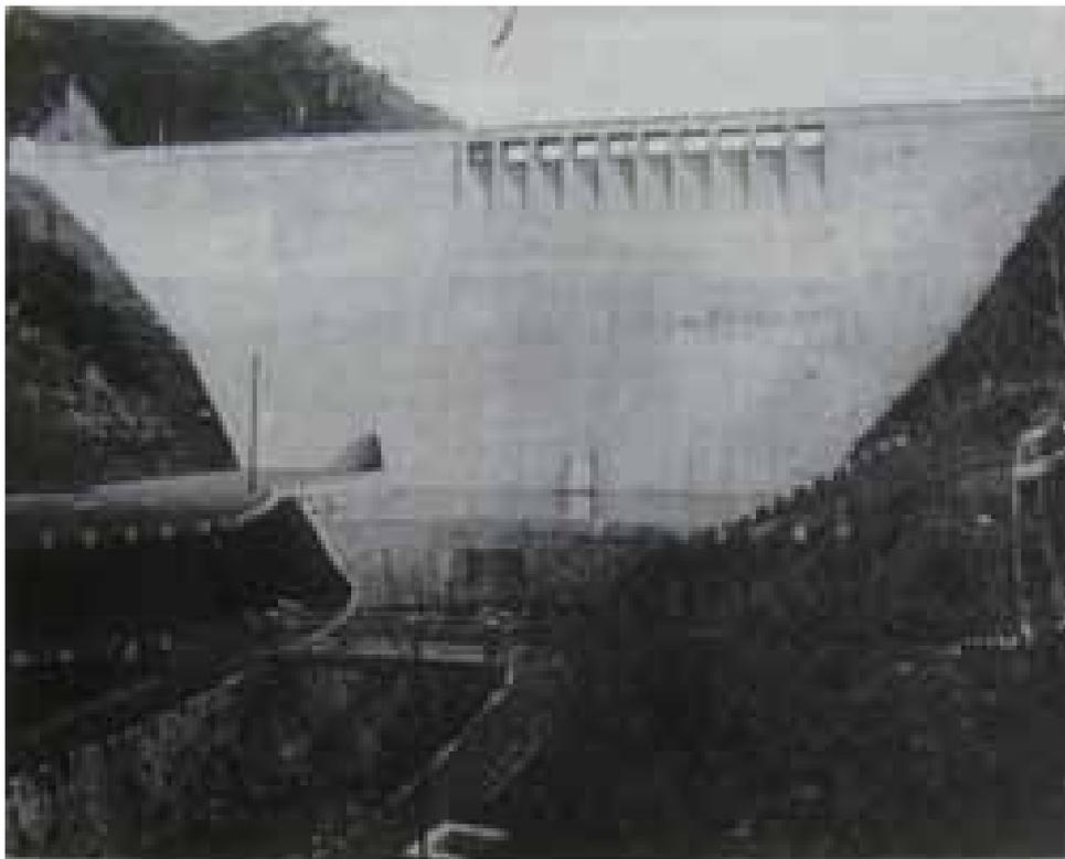
初の鉄筋コンクリート小ヶ倉ダム
