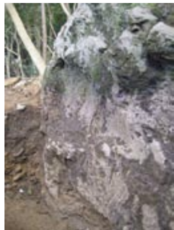
写真4 掘削状況（中心…円形 割付
