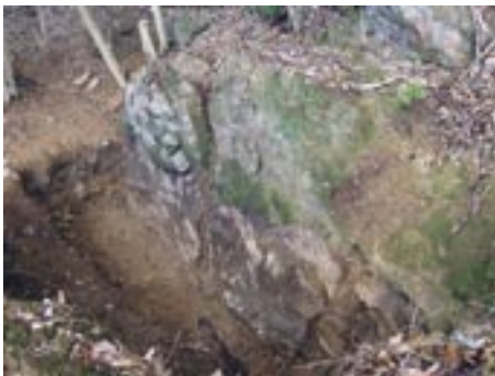
写真3 岩壁面状況（上から）
