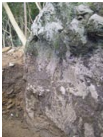
写真4 岸壁面状況（東から）
