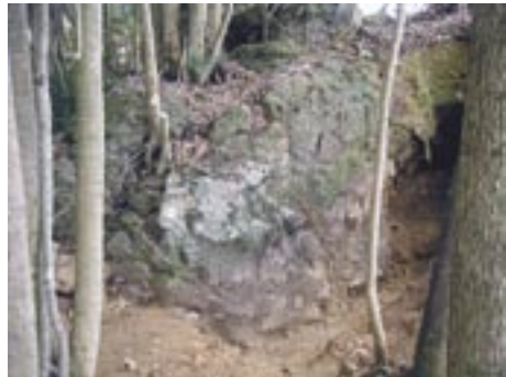
写真2 岩壁面状況（北から）
