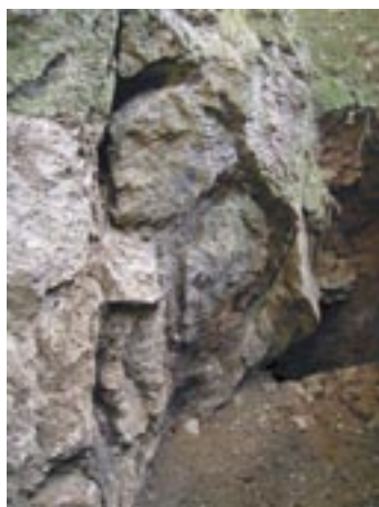
写真6 掘削状況（方形割付と思われる）
